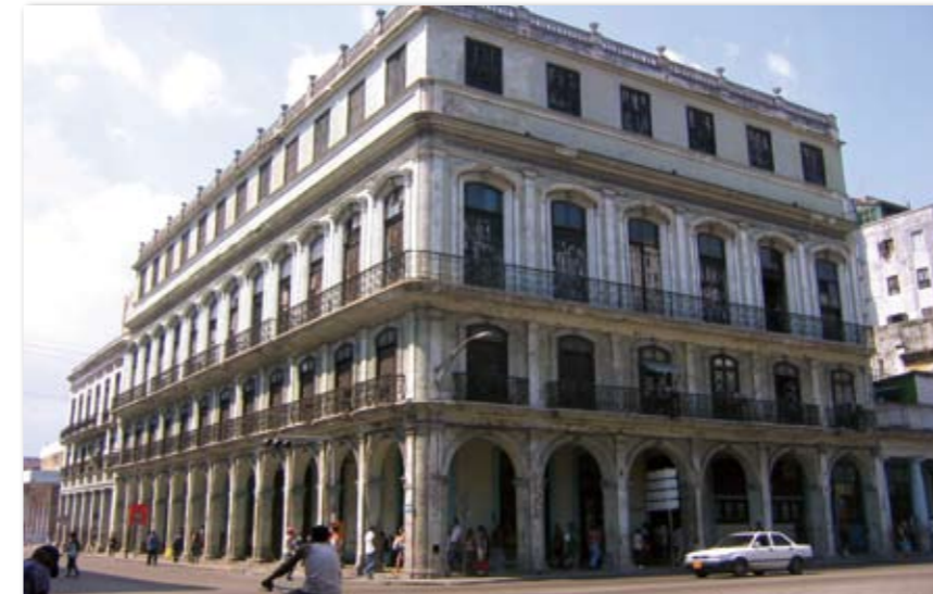
Die Manufaktur „La Escepción“. Vier Etagen waren beim Bau der Cigarrenpaläste eher ungewöhnlich, zwei bis drei die Regel.
